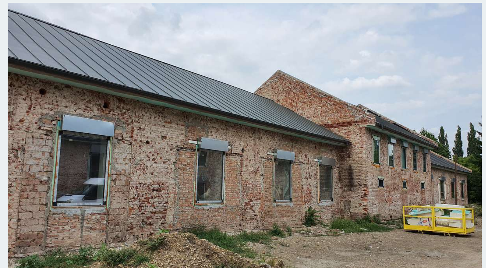
CAMPUS III - CORP CLĂDIRE C53
