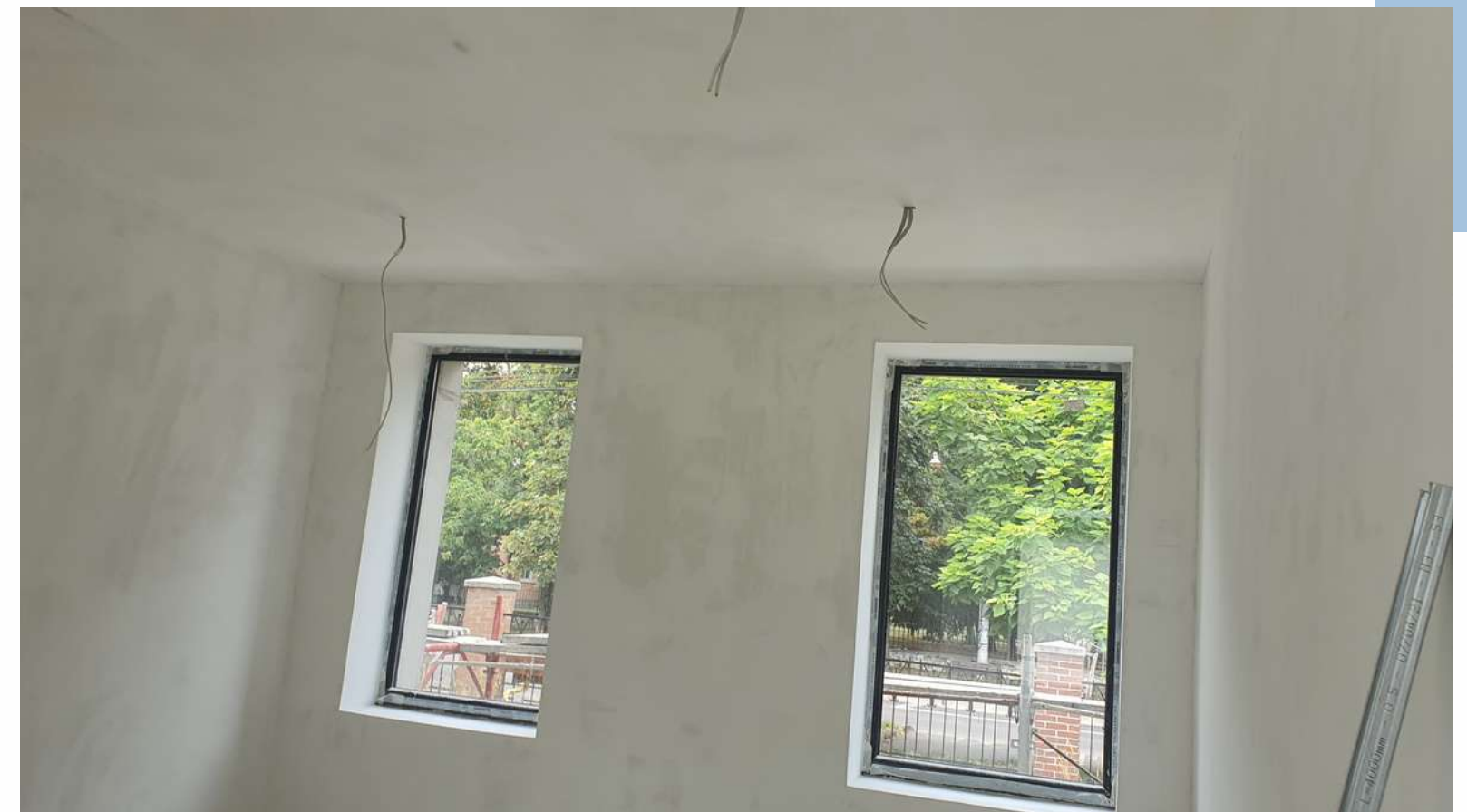
Campus III - Corp Clădire C49 - interior
