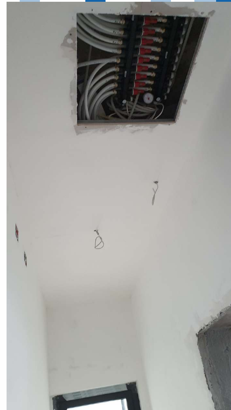
Campus III - Corp Clădire C49 - interior
