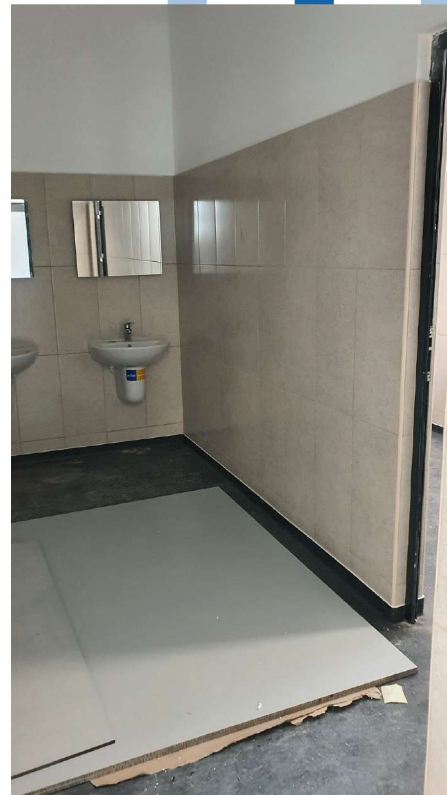
Campus III - Corp Clădire C49 - interior
