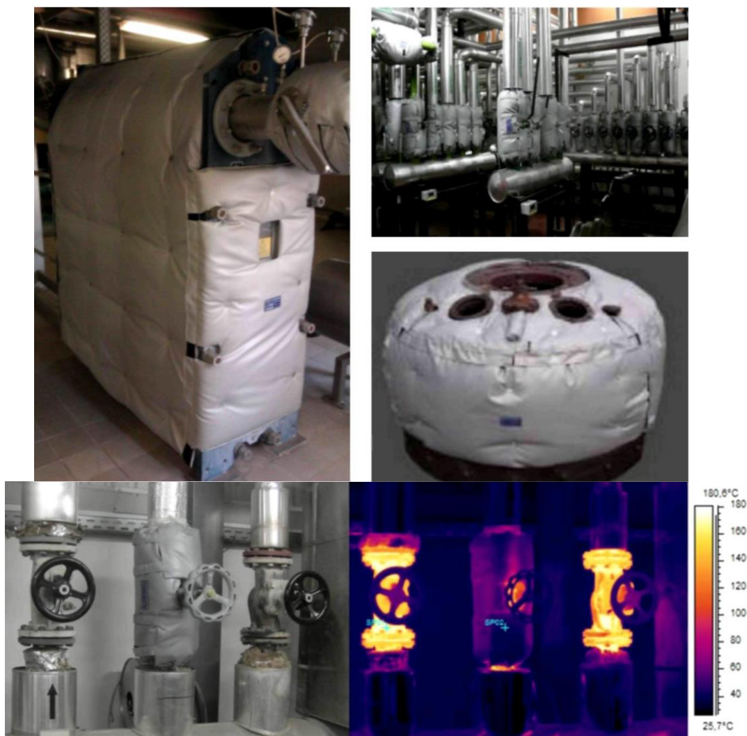
Fig. 5.1 – Izolații termice detașabile
