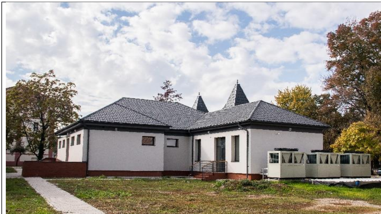
Fig.3. Pompe de căldură- Termocool, Campus B
