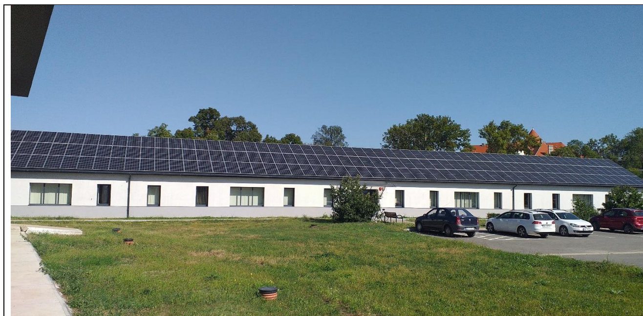
Fig.1. Panouri fotovoltaice-Corp V2-Universitatea din Oradea
