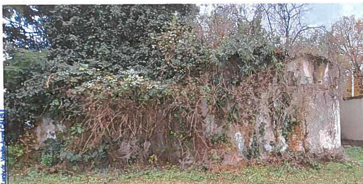
Fig. 5. Construcție existentă 159780 - C5
