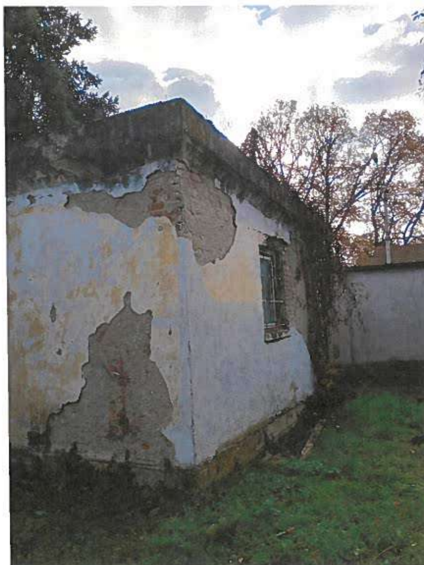
Fig. 6. Construcție existentă 159780 - C6
