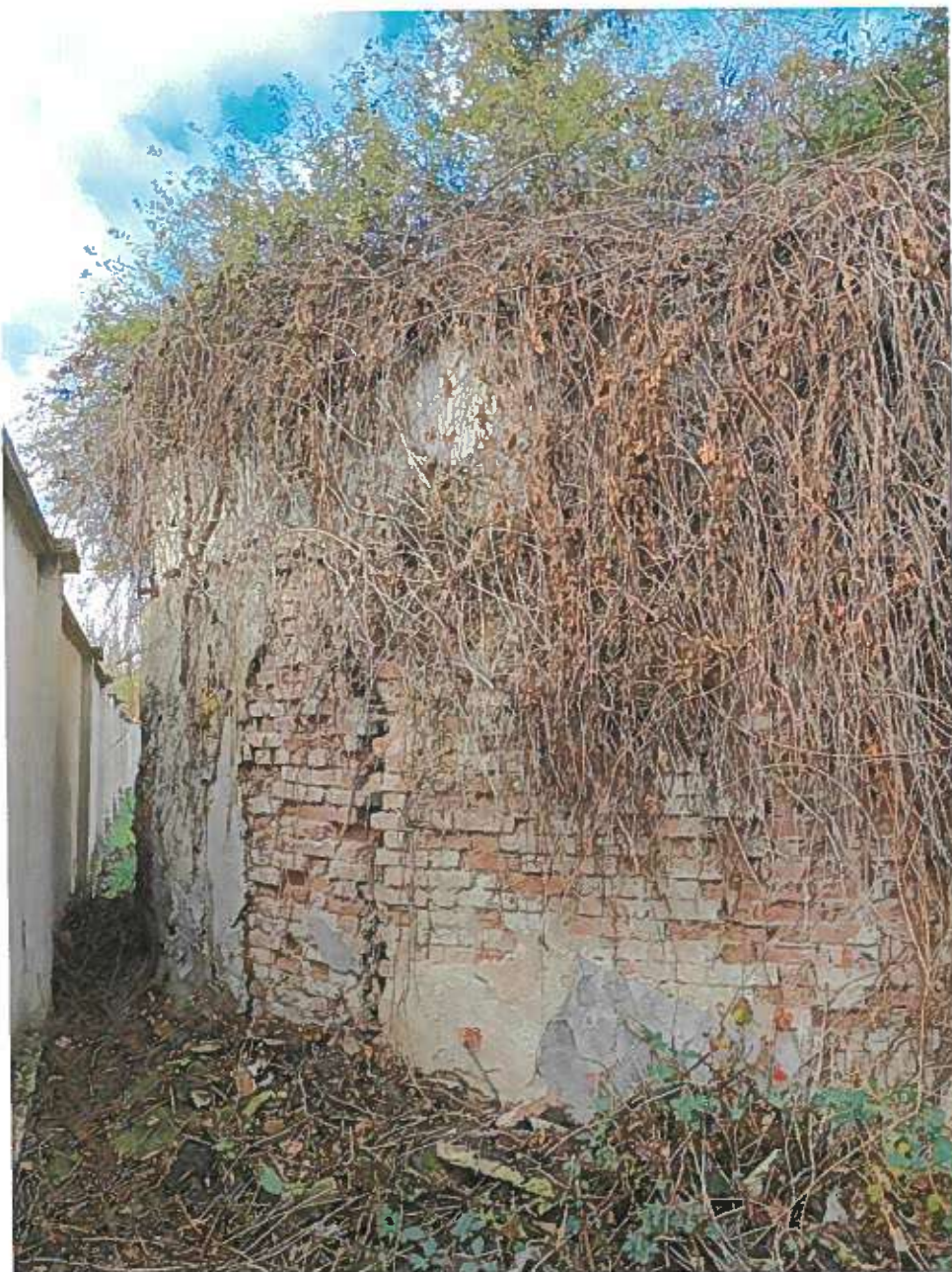
Fig. 6. Construcție existentă 159780 - C5
