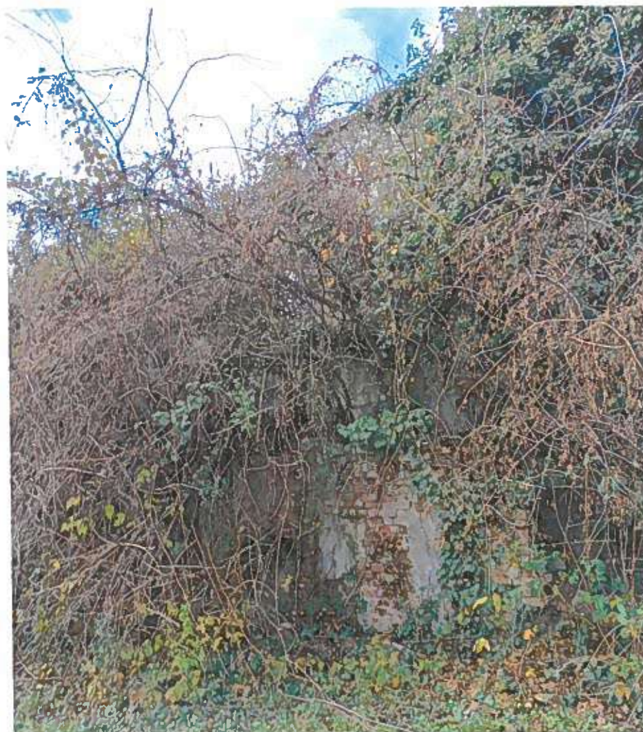
Fig. 7. Construcție existentă 159780 - C5
